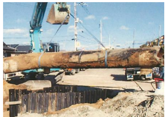
古くなった水道管の撤去作業
